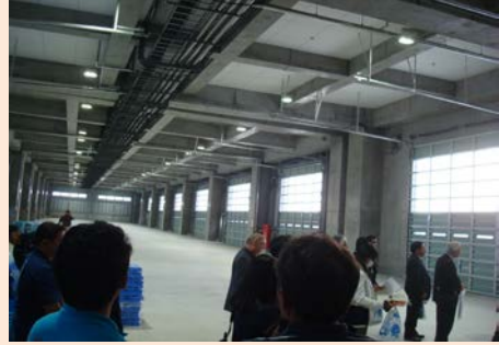
施設内部(津波を考慮した2階利用のため天井高7m)↑
